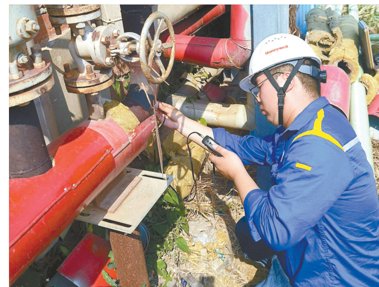
今年6月是第23个全国“安全生产月”。为了保障企业安全生产,日前,省特检院盐城分院检验人员主动提前联系滨海吉尔多肽有限公司,加班加点对该公司蒸汽管道检验检测。现场,检验人员正严格按照相关标准对管道进行宏观检查、超声波测厚等检测。 严扬 摄
