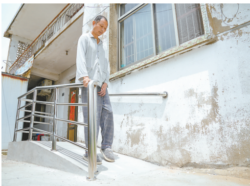
改造安装安全坡道
