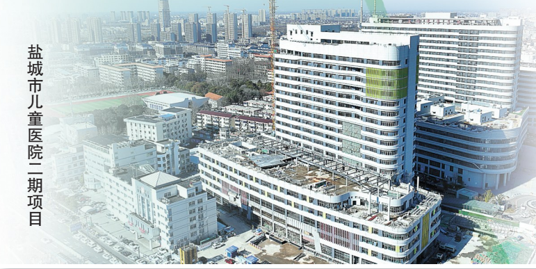
盐城市儿童医院二期项目
