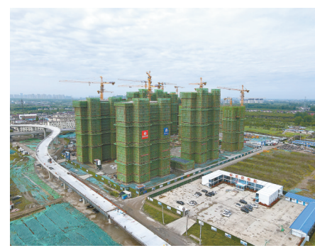
康庄雅苑项目施工现场
