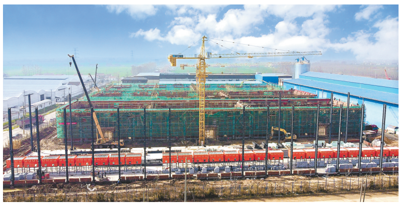
时和年丰二期建设现场
