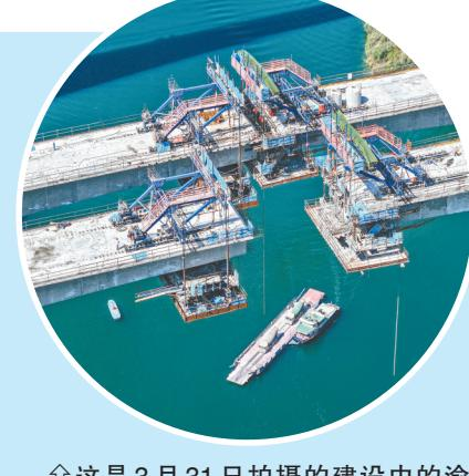
这是3月31日拍摄的建设中的渝湘复线高速黄草乌江特大桥(无人机照片)。当日,由中铁建重庆投资集团参与投资、中铁十五局集团承建的渝湘复线高速公路黄草乌江特大桥连续梁左幅中跨在进行合龙作业。目前该桥完成建设进度90%,进入最后的冲刺阶段,为全线通车奠定了坚实基础。
