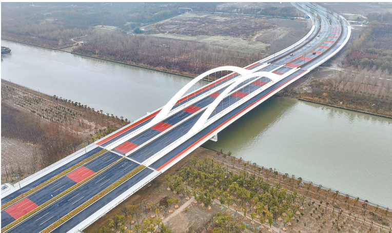
1月31日下午6时，由市住建局组织建设的赣江路—海洋路连接大桥正式通车。该大桥西起海洋路与开放大道交叉口，止于天山南路，全长2.2千米，采用双向6车道城市主干路设计。记者 刘超 摄
