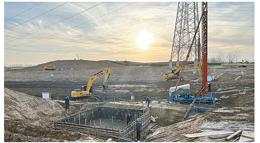
陶圩河闸站是淮入海水道二期工程2023年度新开工工程,设计排涝流量为15立方米每秒,总装机容量1600千瓦,工程批复概算总投资约9300万元。该工程2023年12月开工建设,目前正在推进临时设施搭建、加工场地坪浇筑、主体结构施工,计划2025年汛前完工。陶圩河闸站建成后,会同妇女河泵站、张家河闸站,可有效提高排涝能力,保障滨海县城防洪安全与经济社会发展。
