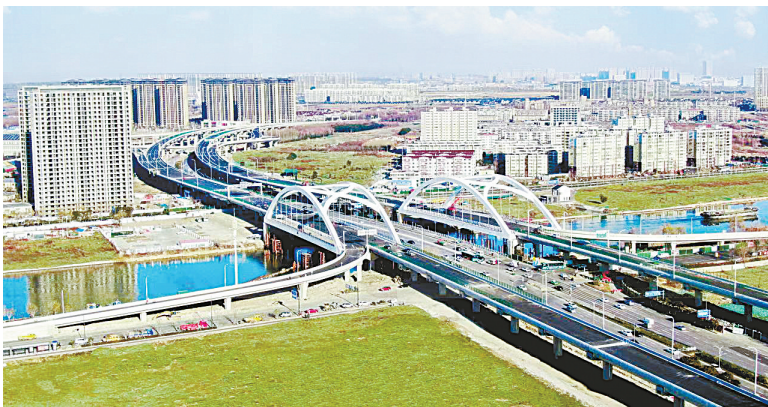
分幅式西环路高架桥
