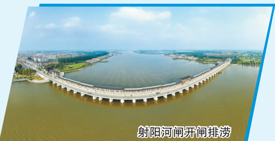
射阳河闸开闸排涝
