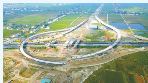
在建的东兴高速
