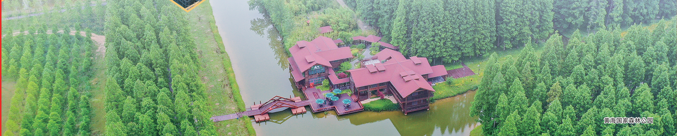
建设中的新中洲项目
