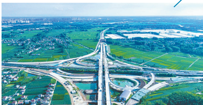
滨淮高速建设现场
