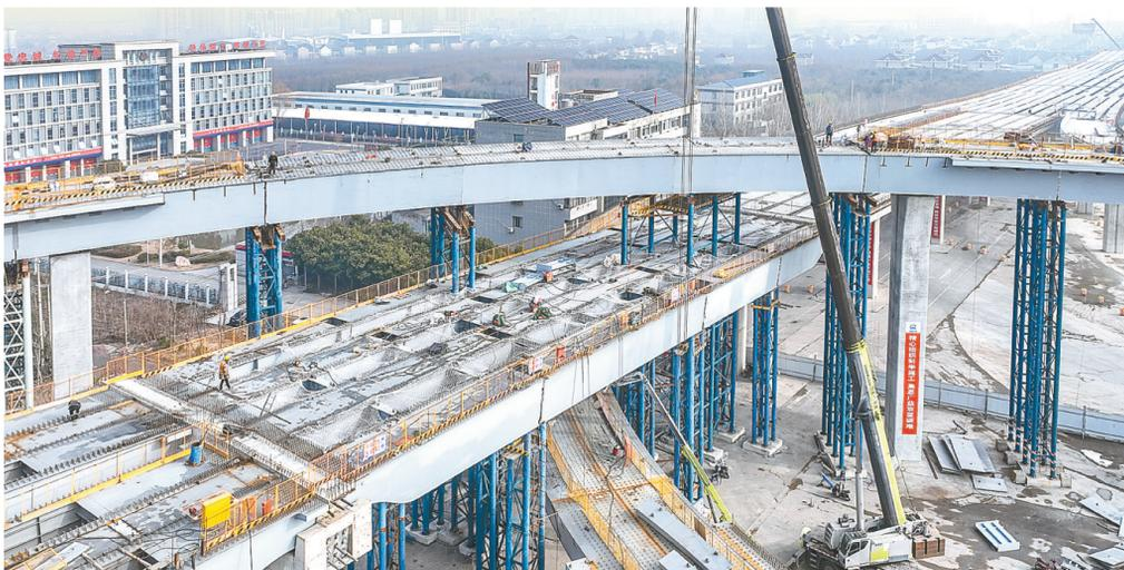
2023年12月31日上午,新业路高架工地施工现场,工人正在对合龙桥梁进行焊接施工。据悉,该项目下部结构完成65%、上部结构完成30%。元旦假期期间,现场一线130余人主要在盖梁、钢梁、路基及桥面附属施工。在寒冷天气施工期间,混凝土浇筑采用篷布覆盖,暖风机加热保温,确保工程优质高效。
