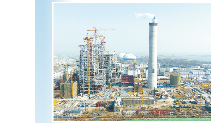
国信滨海港高效清洁燃煤发电项目
