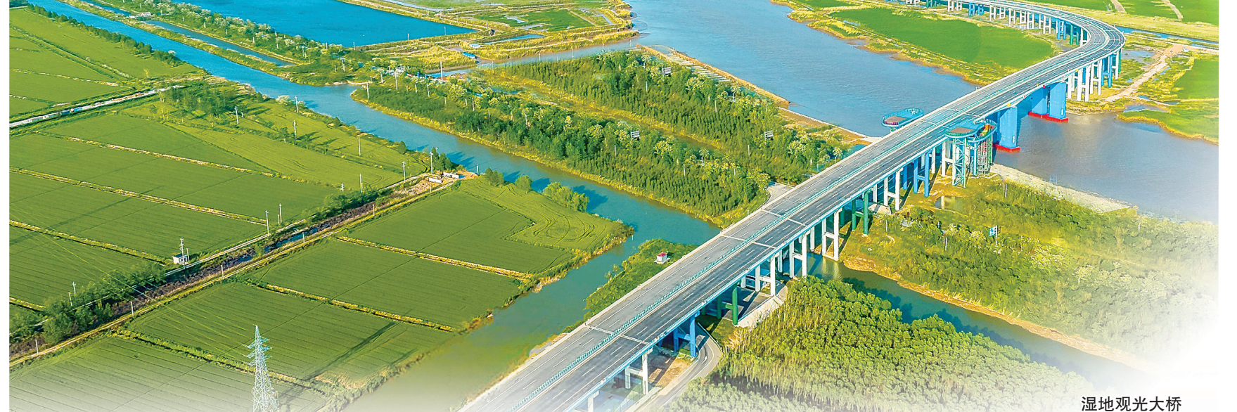
湿地观光大桥
