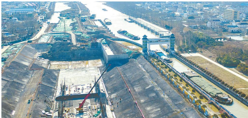
12月20日，位于响水县的连申线灌河至黄响河段航道整治工程现场，工人正在进行闸室底板施工。据了解，该项目的实施，对于打通江苏省东部沿海内河水运南北向主通道的通航“瓶颈”，实现连申线航道与淮河出海航道“并线段”的全线贯通具有重大意义，工程预计2025年底竣工。
