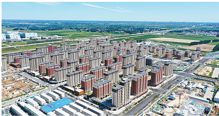
河北雄安新区容西片区安置房(2022年8月25日摄,无人机照片)。新华社记者 朱旭东 摄
