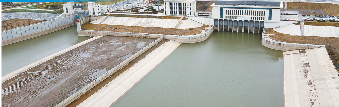
这是12月16日拍摄的引江济淮枞阳泵站(无人机照片)。新华社记者 张端 摄
