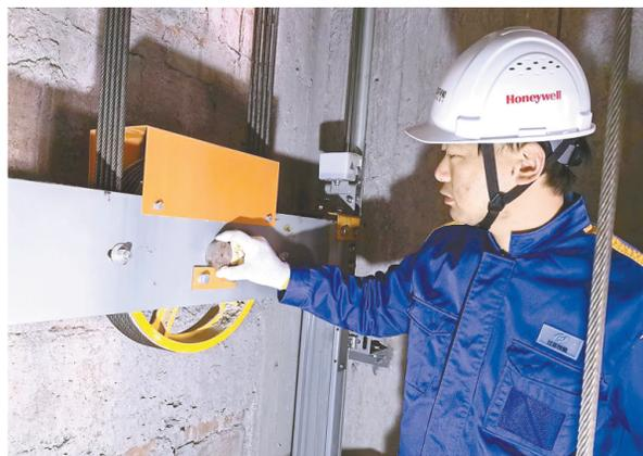
近日,省特检院盐城分院检验员周丹和郭松杰对阜宁县德惠尚书府小区35部电梯进行了年度安全检验。任务繁重且责任重大,两位检验员严格按照检验要求,逐一对电梯的安全报警装置、钢丝绳磨损情况、限速器的安全性能、对重轿厢护栏距离、对重绳轮轴等进行了细致全面检查,确保每一部电梯都符合安全使用标准。
