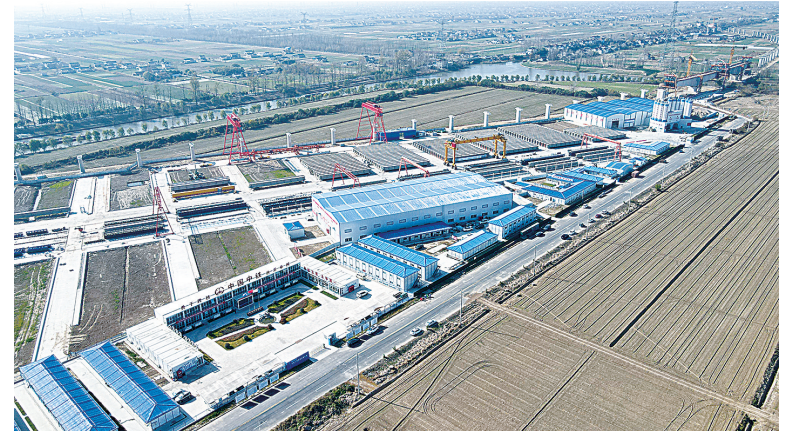
大丰制梁场近日顺利通过T梁取证,标志着大丰制梁场已经具备大规模生产高质量T梁的能力,为大丰港铁路项目施工大干提供了坚实保障,极大地鼓舞了全体参建人员的信心。张丹丹 摄
