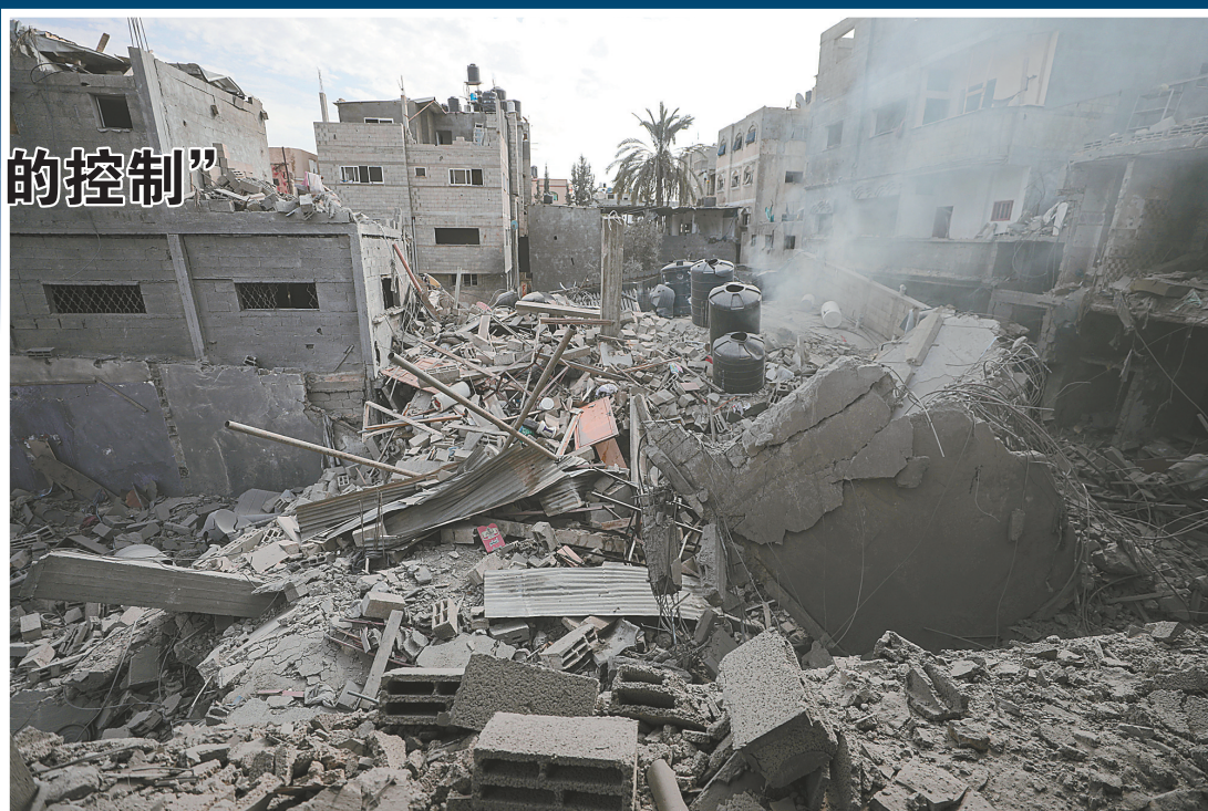
11月13日在加沙地带中部地区拍摄的一个遭以色列空袭的建筑废墟。新华社发(里泽克·阿卜杜勒贾瓦德 摄)
