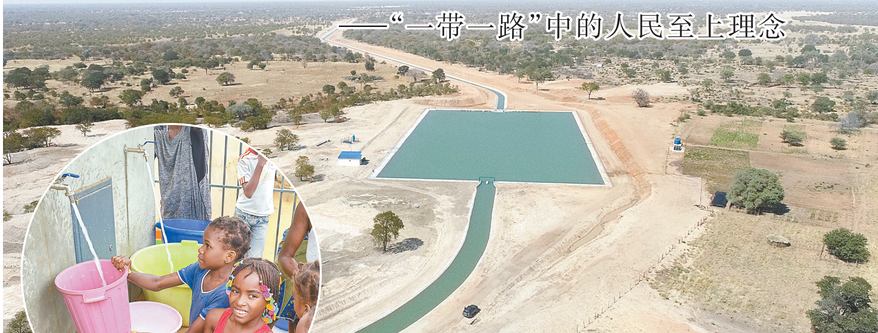
这是由中国电力建设集团承建的安哥拉库内内省抗旱工程的渠道和集水池(2022年摄,无人机照片)。新华社发(中国电力建设集团供图)
