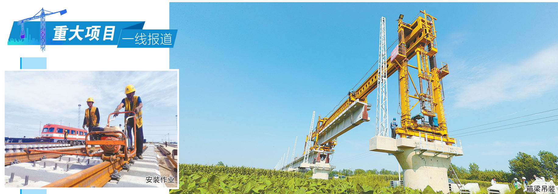
滨海港铁路支线是省重点工程，全长50.8公里，起点为青盐铁路滨海港站，终点为滨海港工业园区，是一条服务滨海港和临港企业同时兼顾周边区域的铁路专用线。该项目于2021年3月开工，计划2023年年底建成通车。截至目前，铁路支线桥梁上下部结构和T梁预制已全部完成。 记者 杨毅 通讯员 陈其龙 王则军 摄
