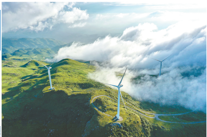
位于贵州省赫章县韭菜坪上的风力发电设备(无人机照片,2020年8月19日摄)。新华社记者 刘续 摄
