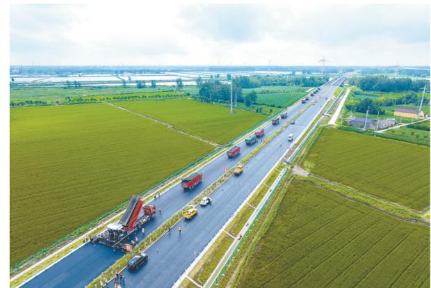
8月1日上午，在阜宁至溧阳高速公路建湖至兴化段镇江路桥JHX-21标沥青中面层施工现场，1台大型摊铺机正将滚烫的沥青均匀摊铺在道路上，5台压路机紧随其后，来回有序碾压。此次施工设备采用高精度北斗定位、自动控制、智能感知、群控安全、任务协同等技术，实现摊铺机、压路机无人驾驶，结合辅助压实、主动安全避障等技术实现人工智能化机群摊铺碾压，在全省高速公路建设项目中属首次应用。同时，全国首创在高模量沥青施工中采用无人摊铺施工工艺。
