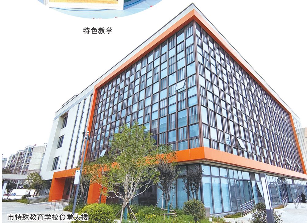
市特殊教育学校食堂大楼
