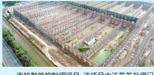
海核智能控制阀项目:该项目由江苏海核阀门机械有限公司投资建设,当期计划投资15亿元,年产石油化工海洋核电等工业用智能控制阀8万台套。
