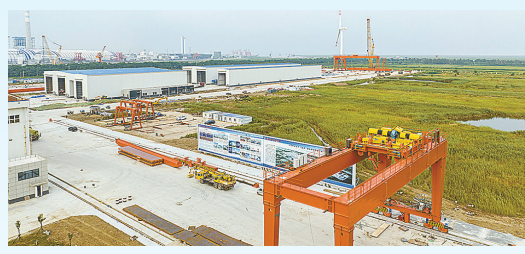
大连重工塔筒及内件项目:该项目由大连华锐重工集团股份有限公司投资建设,当期计划投资30亿元,年产风电塔筒30万吨。
