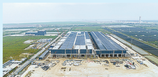
中车时代新材百米级叶片智造项目:该项目由株洲时代新材料科技股份有限公司投资建设,当期计划投资35亿元,年产海上大兆瓦级叶片300套。
