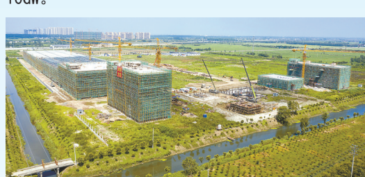
智泰20GWh固态储能电池项目:该项目由江苏智泰新能源科技有限公司投资建设,当期计划投资100亿元,年产储能电池20GWh。
