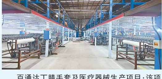
百通达丁腈手套及医疗器械生产项目:该项目由百通达(盐城)医疗科技发展有限公司投资建设,当期投资5亿元,年产PVC医用手套45亿只。
