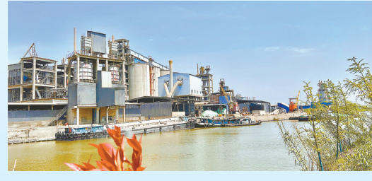
磊达节能改造项目:该项目由东台磊达水泥有限公司投资建设,当期投资10亿元,对水泥生产线粉磨系统辅助设备更新升级。
