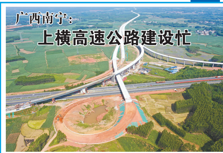
7月26日在广西宾阳县拍摄的施工中的上横高速公路(无人机照片)。
