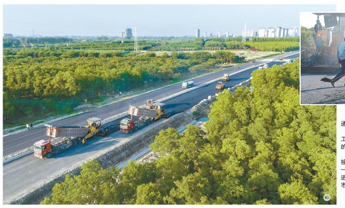
①7月5日,343国道盐丰快速 通道YF1标沥青摊铺项目稳步推进。 ②当日最高气温35摄氏度,施 工人员不畏高温和炽热沥青拌合料 的烘烤,快速推进道路沥青施工。
