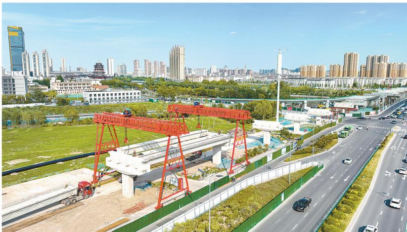
市区西环路高架北延项目现场，工人们在各自岗位上紧锣密鼓地进行施工作业。西环路高架北延项目作为城北地区改造重点工程，全长双幅3.15公里。目前，高架下部基础施工已完成87%，上部梁片已预制430片，主线桥预计年底竣工，完全建成后将极大缓解城北片区交通压力。
