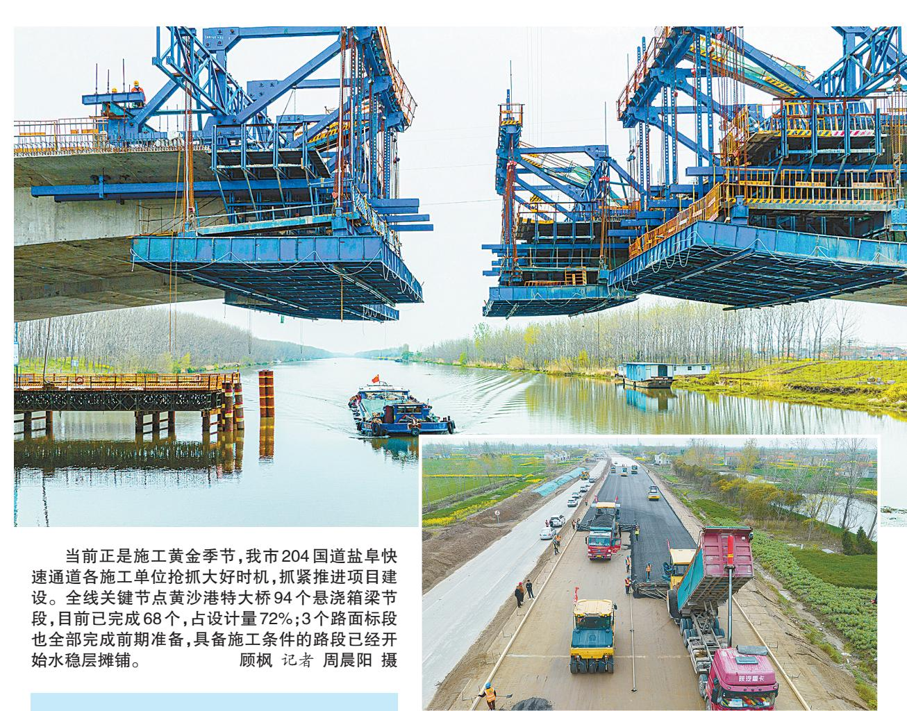
当前正是施工黄金季节，我市204国道盐阜快速通道各施工单位抢抓大好时机，抓紧推进项目建设。全线关键节点黄沙港特大桥94个悬浇箱梁节段，目前已完成68个，占设计量72%；3个路面标段也全部完成前期准备，具备施工条件的路段已经开始水稳层摊铺。
