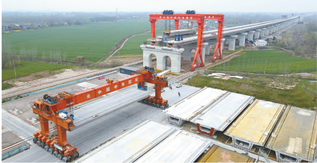
↑这是3月29日拍摄的中铁四局巢马城际铁路箱梁架设现场(无人机照片)。 新华社记者 汪海月 摄
