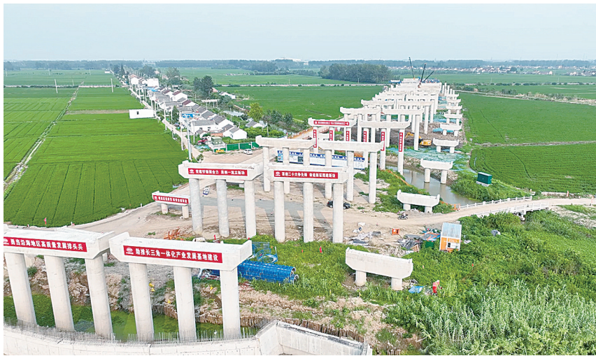
图为项目建设现场
