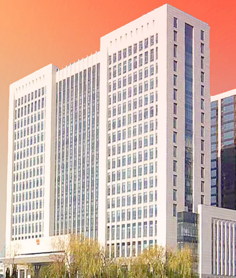
2011年 盐城市中级人民法院审判办公综合楼(府南路1号)
