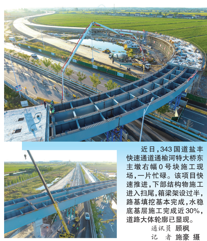
近日，343国道盐丰快速通道通榆河特大桥主墩右幅0号块施工现场，一片忙碌。该项目快速推进，下部结构物施工进入扫尾，箱梁架设过半，路基填挖基本完成，水稳底基层施工完成近30%，道路大体轮廓已显现。 通讯员 顾枫 记者 施豪 摄
