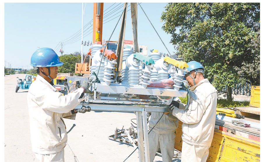
10月11日,国网滨海县供电公司组织施工人员对10千伏欧北线2号开关进行更换作业,消除设备缺陷,提高供电可靠性,为电网安全稳定运行保驾护航。 周吉成 摄
