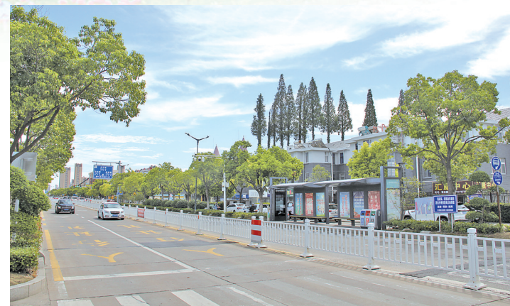
幸福大街公建提升工程
