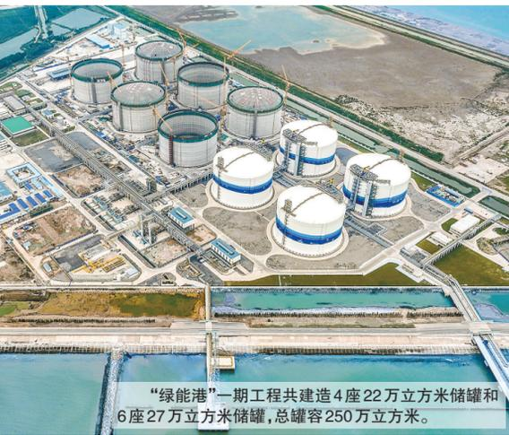
“绿能港”一期工程共建造4座22万立方米储罐和6座27万立方米储罐，总罐容250万立方米。
