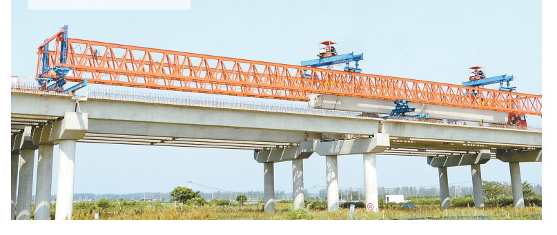
9月7日上午，随着最后一块桥面板精准安装到位，阜溧高速公路大纵湖段正式合龙。阜溧高速公路纵贯江苏省腹地，对完善区域高速公路网、带动沿线经济社会发展有着重要意义。通讯员 刘庆宝 记者 单丹摄
