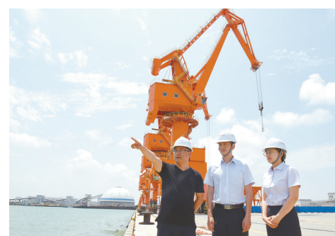
实地了解项目建设情况
