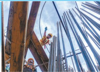
204国道盐阜快速通道自去年8月底开工以来，各参建单位克服困难，科学组织施工，确保工程稳步推进。截至8月底，全线桥梁结构物累计已完成桩基施工超5000根，占设计量94%；桥墩和墩柱完成量分别超八成、七成；预制箱梁已制作600根、安装325根，分别占总量19%和10%。
