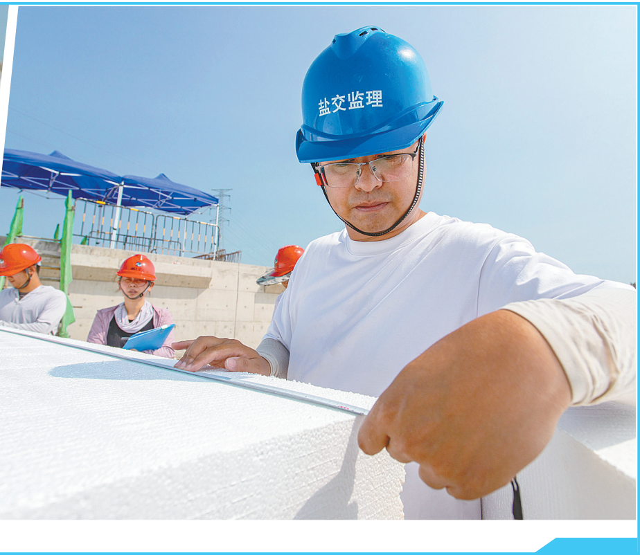
8月24日,盐阜快速通道施工现场,项目工程师用钢卷尺和磅秤,对每一块进场EPS料块进行检查验收。他们将料块一一编号,登记尺寸和重量。EPS料块作为一种超轻质材料,将它填筑在路桥过渡段路基里,可以实现刚性桥梁与柔性道路之间的均匀过渡,有效缓解“桥头跳车”问题。 顾枫 摄
