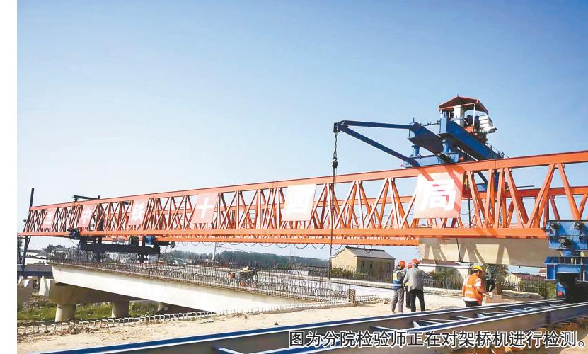
图为分院检验师正在对架桥机进行检测。
