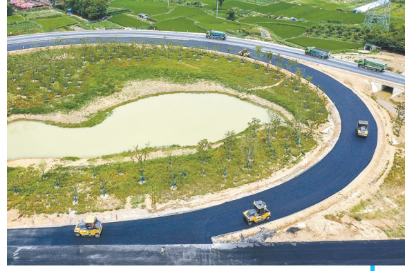
7月26日,工人在周城互通路段铺设沥青路面。
