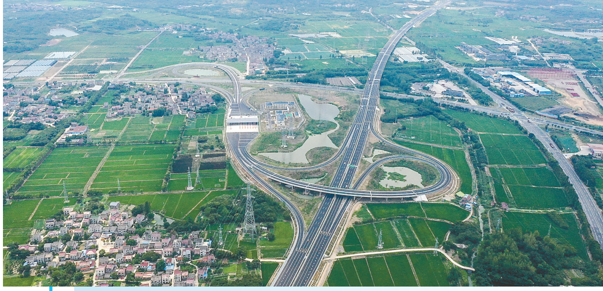
7月26日,南渡南枢纽的部分路段已经建成通车(无人机照片)。 溧阳至宁德高速公路江苏段是国家高速公路的重要组成部分,北接扬溧高速,南接溧宁高速公路安徽段,全长23.724公里,设计时速120公里。目前,工程建设进入冲刺收尾阶段,全线将于年内建成通车。项目的建设对完善长三角地区高速公路网,缓解大湖西侧南北向通道压力,加强苏南地区与皖南地区的联系起着重要作用。 新华社记者 杨磊 摄
