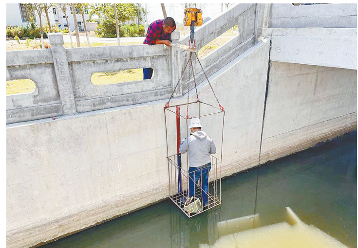
近日,东台市富安镇防汛抗旱指挥部组织专业人员,对5个圩区内部分圩口闸更换老旧水位尺12处。新水位尺安装后,不仅方便于群众时了解水位,而且为领导决策关闸排涝提供准确、直观的依据。
