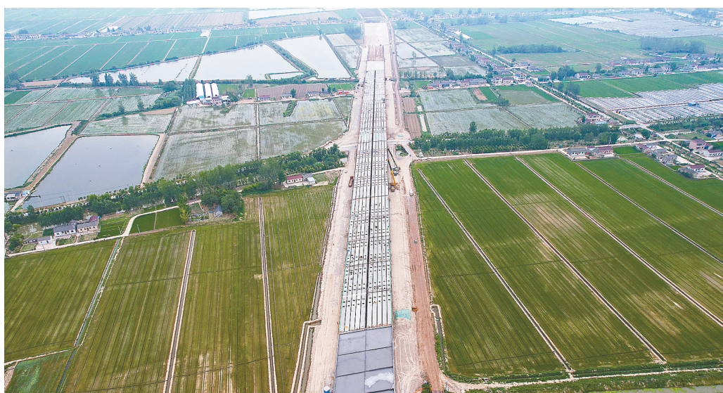
7月14日下午，中铁十四局集团有限公司参建的343国道大丰至盐城段工程YF3标项目主线桥上跨刘高线分离式立交桥箱梁成拱架设。下一步，项目部将不断优化各类资源配置，高效率推进盐丰一体化建设进程。 通讯员 王生祥 记者 王焱 摄
