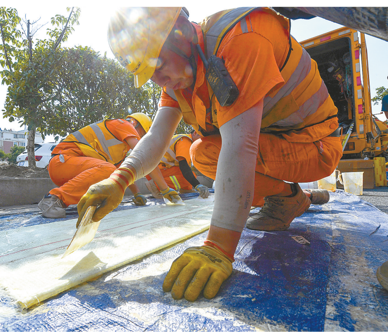
7月13日上午，最高气温37℃以上，在市区西环路上，市政工人头顶烈日修复雨水排水管道，保障「城市血管」的畅通。目前，市市政设施管理处对解放路、人民路、西环路等主次干道排水管网进行检测，重点排查错口、起伏、脱节、渗漏等问题。
