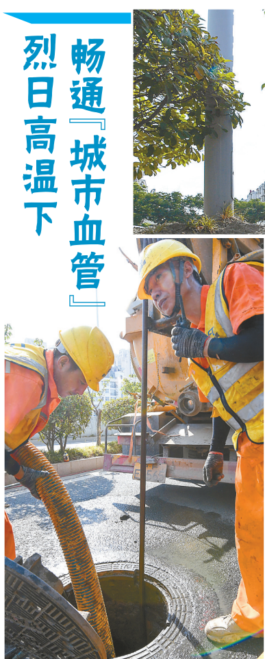
7月13日上午，最高气温37℃以上，在市区西环路上，市政工人头顶烈日修复雨水排水管道，保障「城市血管」的畅通。目前，市市政设施管理处对解放路、人民路、西环路等主次干道排水管网进行检测，重点排查错口、起伏、脱节、渗漏等问题。
