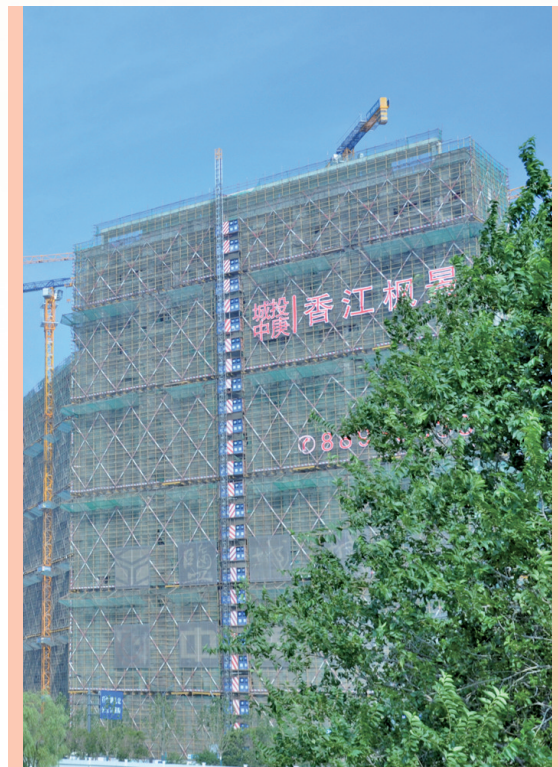
建设中的香江枫景安置房
