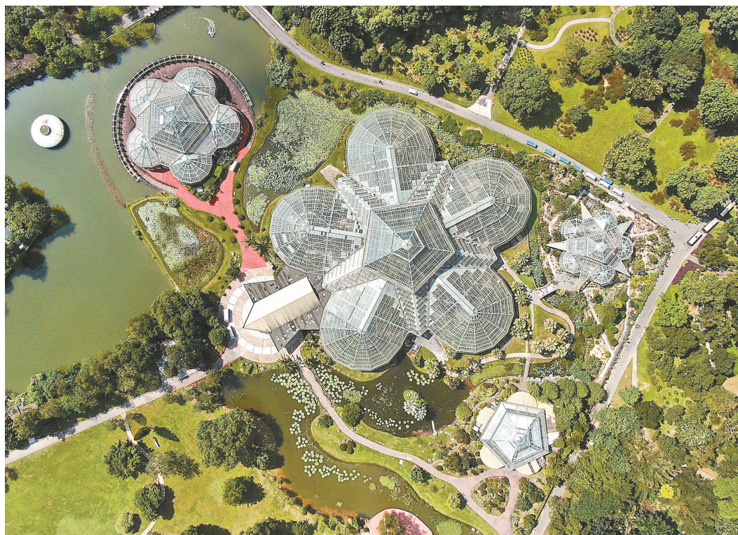
7月11日拍摄的华南国家植物园展览温室群(无人机照片)。
