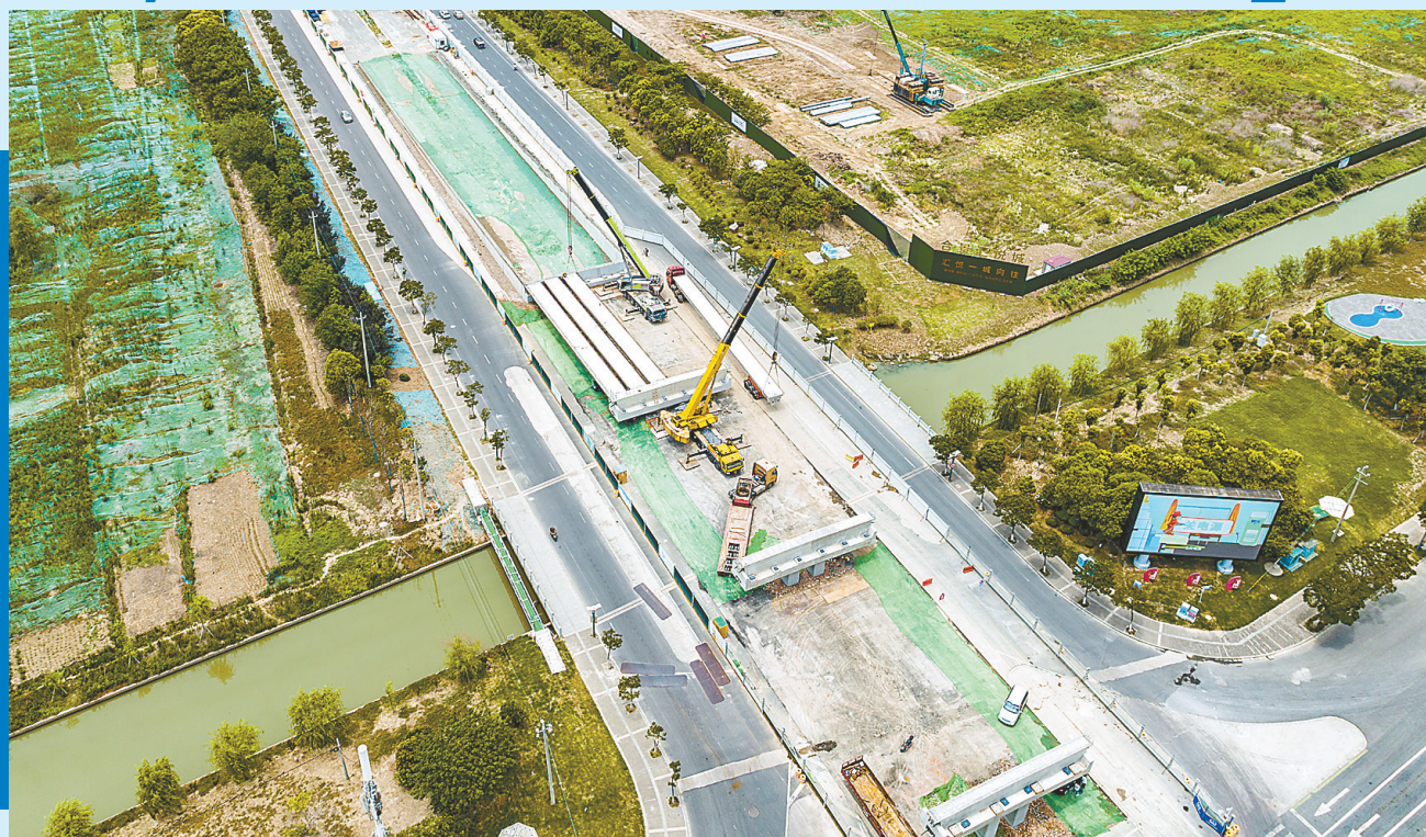
7月4日，中铁四局盐城快速路及基础设施项目青年路西延工程首件预制箱梁成功架设，标志着市区青年路西延工程全面进入上部结构施工阶段。该项目线路全长约2.44公里，采用全线高架，双向四车道，西起振兴路西侧，东接青年路及G204快速路主线。 通讯员 周勇忠 记者 施豪 摄
