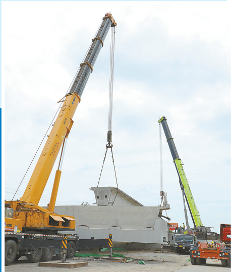
7月4日，中铁四局盐城快速路及基础设施项目青年路西延工程首件预制箱梁成功架设，标志着市区青年路西延工程全面进入上部结构施工阶段。该项目线路全长约2.44公里，采用全线高架，双向四车道，西起振兴路西侧，东接青年路及G204快速路主线。 通讯员 周勇忠 记者 施豪 摄
