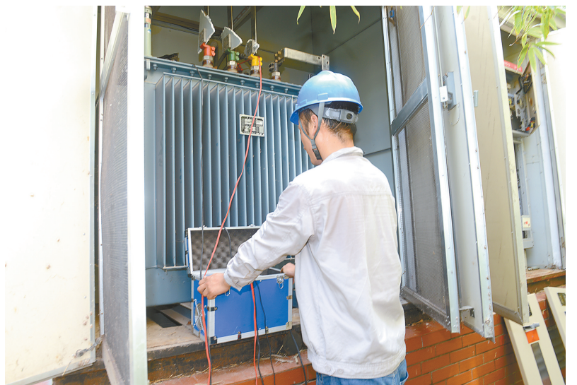
6月29日,滨海县城景湖理想城小区C区1号欧式箱变因负荷发生故障,国网滨海供电公司组织抢修队员立即奔赴现场,冒着36摄氏度高温突击抢修更换故障配变,确保市民高温季节清凉用电。 周吉成 摄
