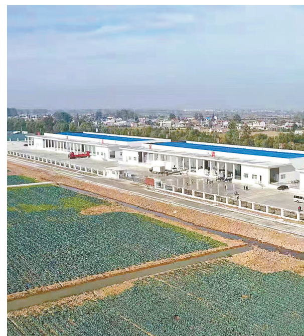
全国单体最大的西兰花专用冷藏库——响水县宝青冷库
